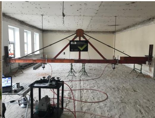
Belastungstest der vorhandenen Decke
